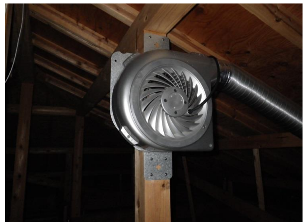
換気扇設置完成図
