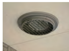
軒天用丸・平換気口 (丸穴取付) N-125STV2-A3
