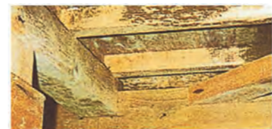
A 床下換気扇を設置していない床下
